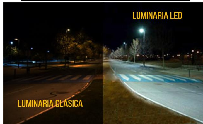
FIGURA 67. LUMINARIA CLÁSICA VS LUMINARIA LED
